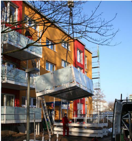
Voorgevel (verwijdering asbest, isolatie en nieuwe gevelbekleding + zonwering)
