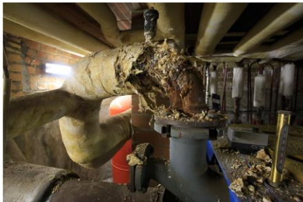
Verwarmingsleidingen kelder de leidingen zijn omwikkeld met isolatie en plaaster. Een dergelijke toepassing kan niet-hechtgebonden asbest bevatten.
